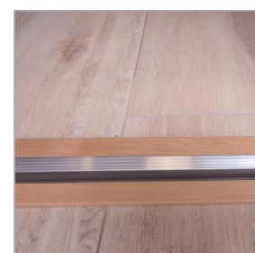
próg dębowy do ościeżnicy drewnianej
