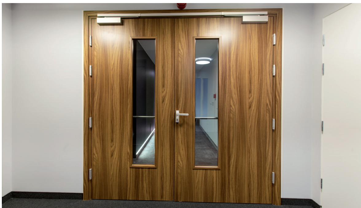
drzwi przeciwpożarowe FR EI30, ościeżnica stała drewniana
